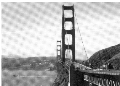
モアレが発生した例
