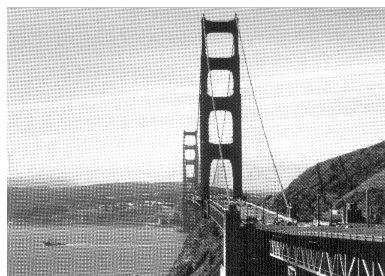
モアレが発生した例
