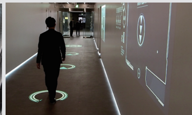
導線に沿って天井に11台のEV-100を配置。同じく天井に配置された人感センサーと連動するようにしている(写真・左)。右壁面のパネルを操作することで道案内が開始。人が矢印を通過すると矢印が消える(同・右)。
