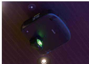
木目パネルの入った天井に配置されるプロジェクターには、黒筐体のEB-1405Uを使用。できるだけ筐体が目立たないように工夫されている。
