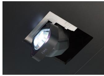
プロジェクター本体はビルトインされ、超短焦点レンズのみが天井に見える状態。没入感の効果を上げている。
